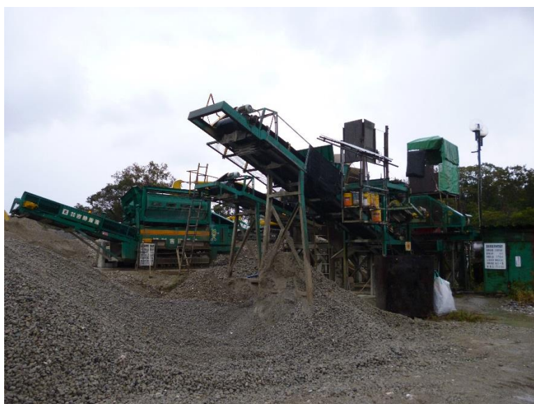
三国営業所（がれき破碎機）
