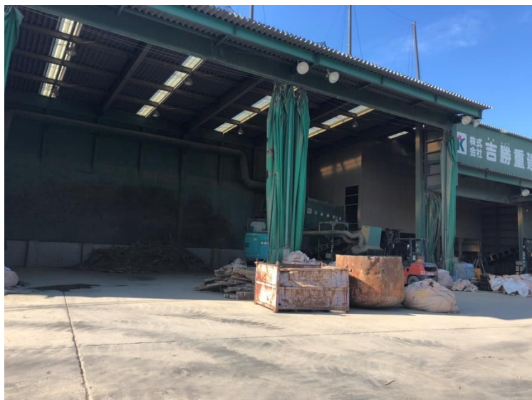
長浜リサイクルセンター（選別施設）
