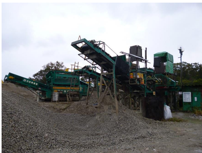
三国営業所（がれき破碎機）
