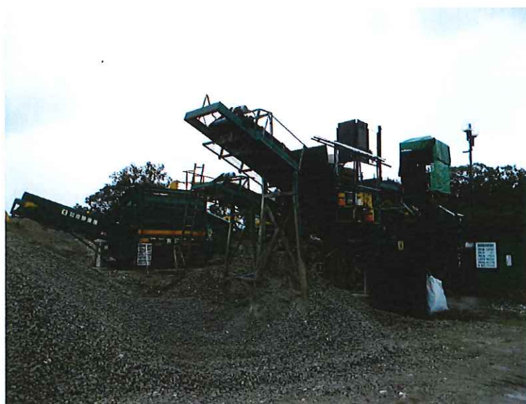
三国営業所 (がれき破碎機)
